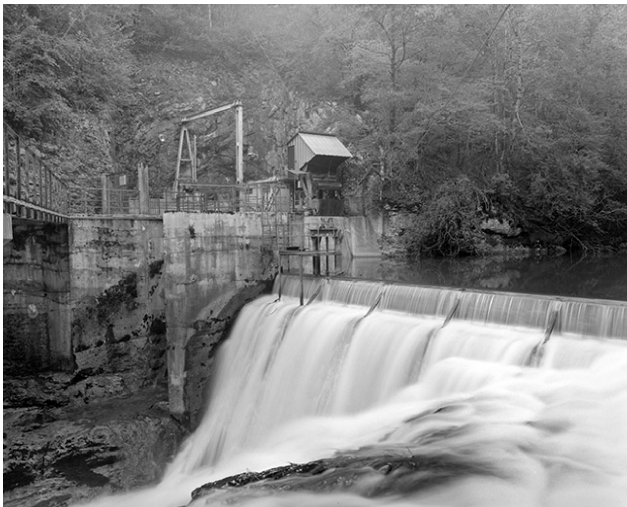
Prise d'eau et barrage.
