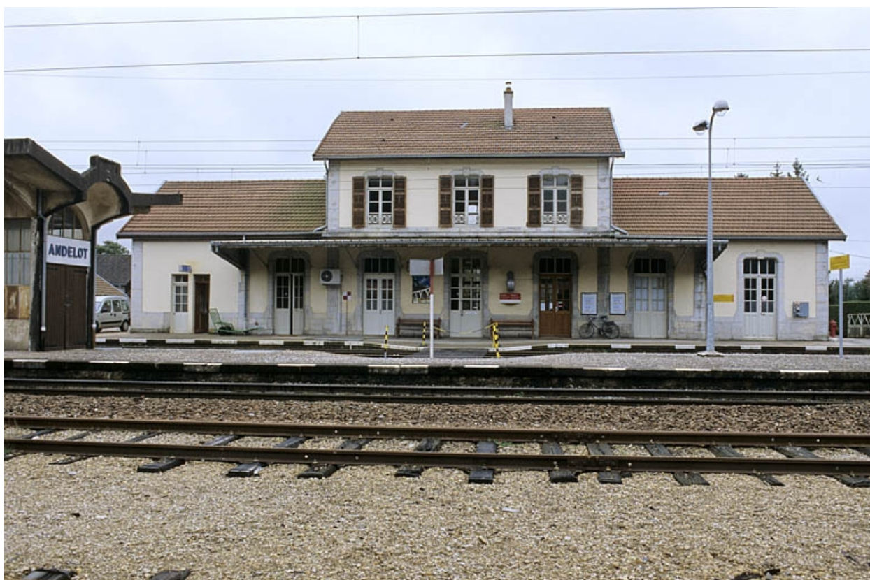
Bâtiment des voyageurs : façade postérieure, de face.
