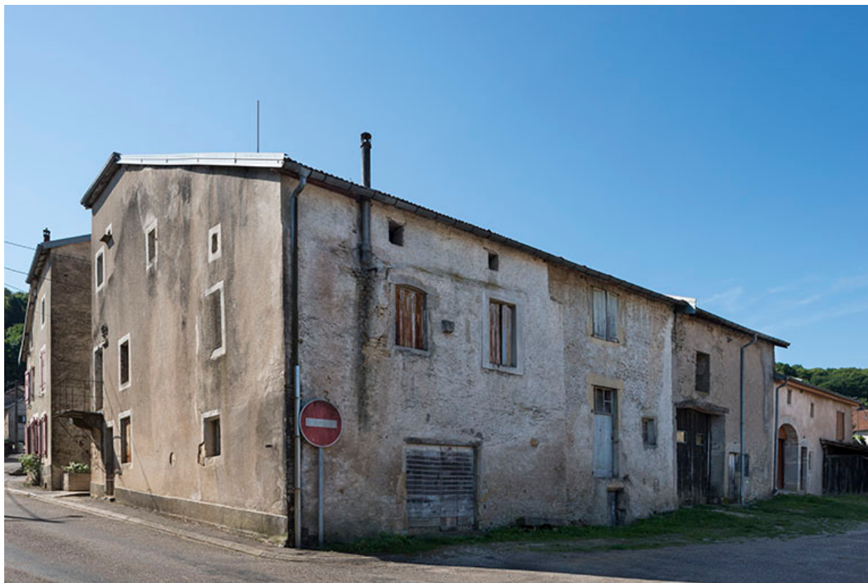
Vue depuis le nord.
