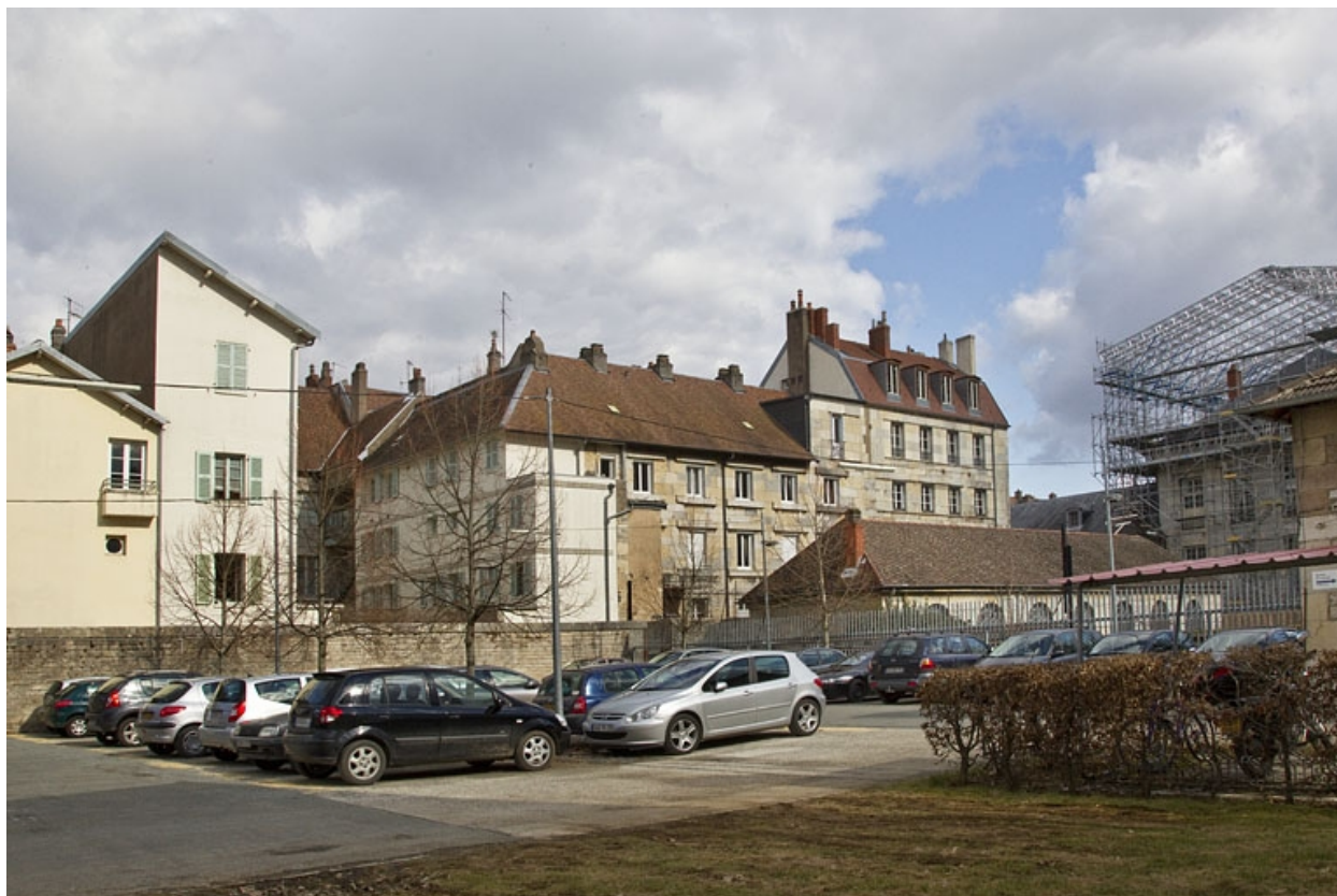
Vue d'ensemble éloignée de l'arrière de l'édifice.
