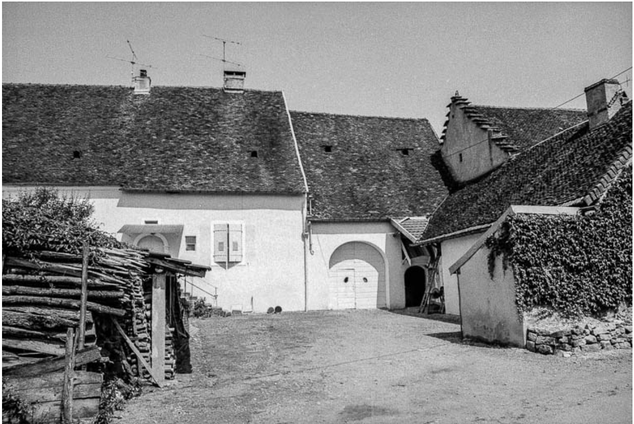
Ferme cadastrée 1960 AE 165, située rue Saint-Christophe : façade antérieure.
