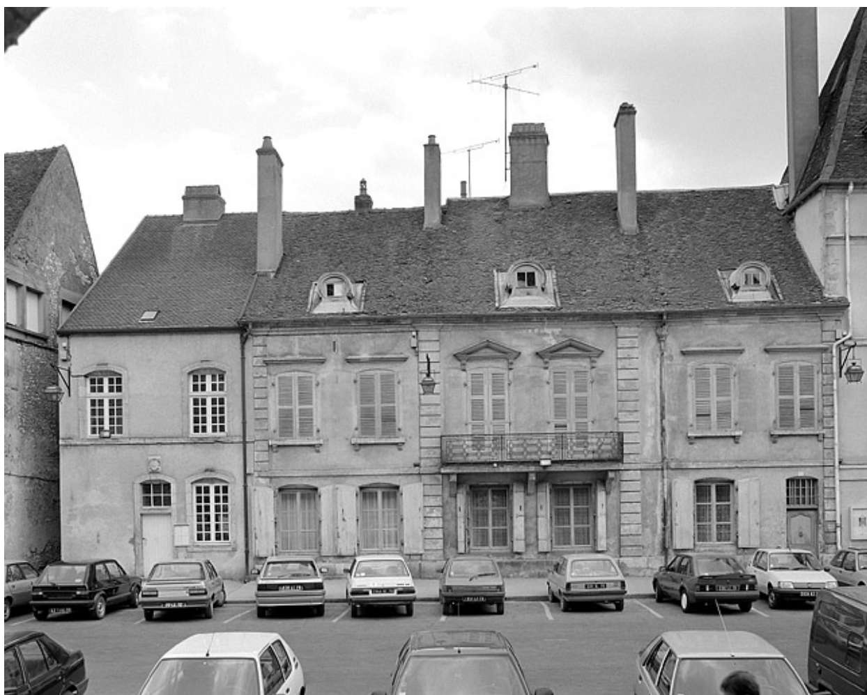
Façade antérieure de l'édifice principal, de face.
