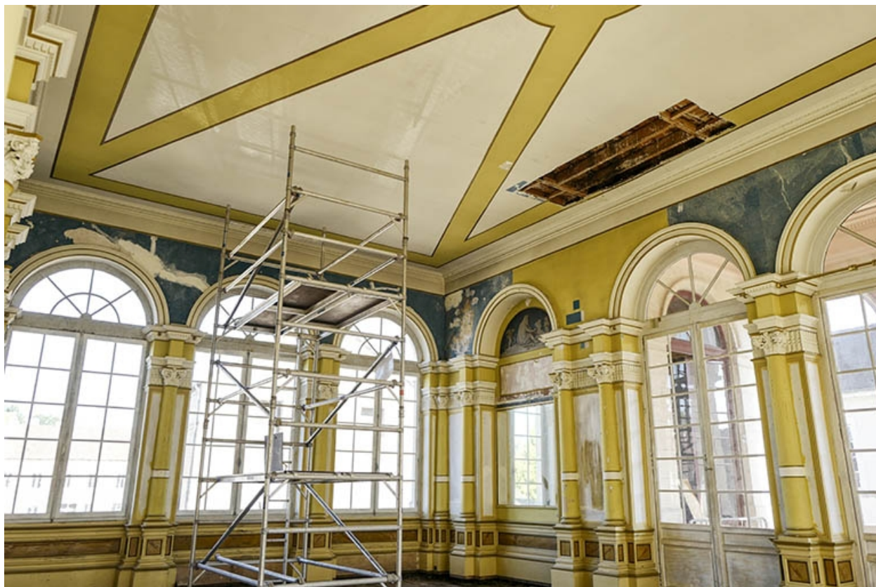
Foyer en cours de restauration, en 2020.
