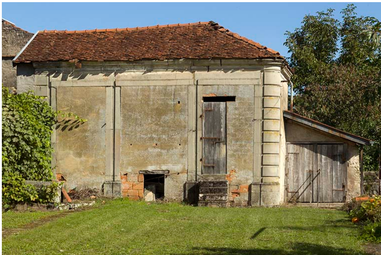
Façade sud de l'édicule du jardin.
