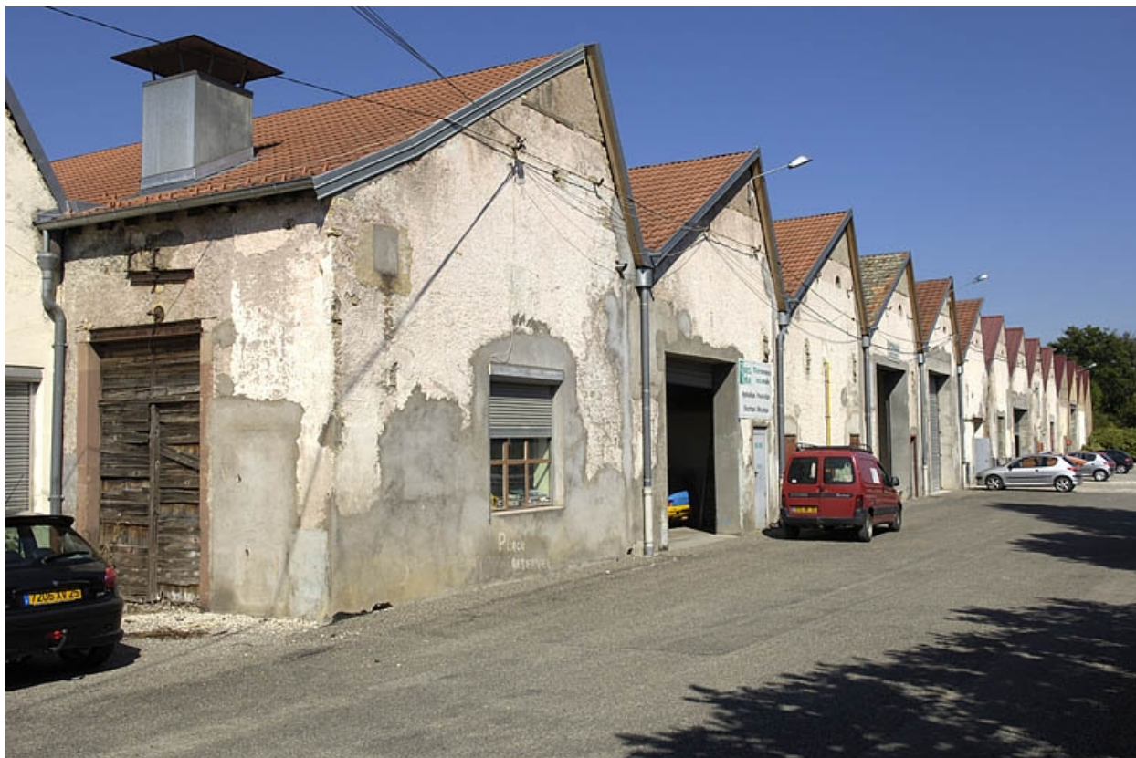
Murs-pignons sud du tissage.
