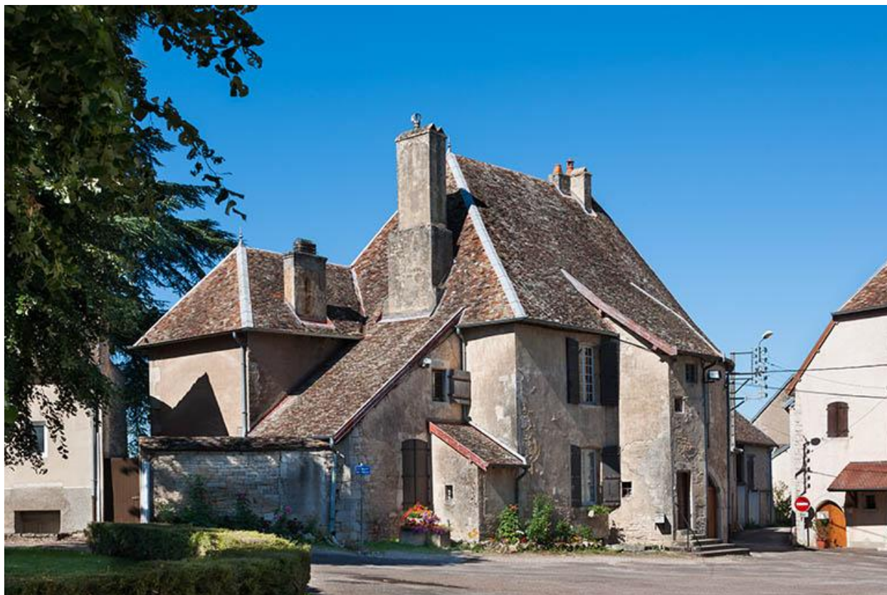
Vue générale sud
