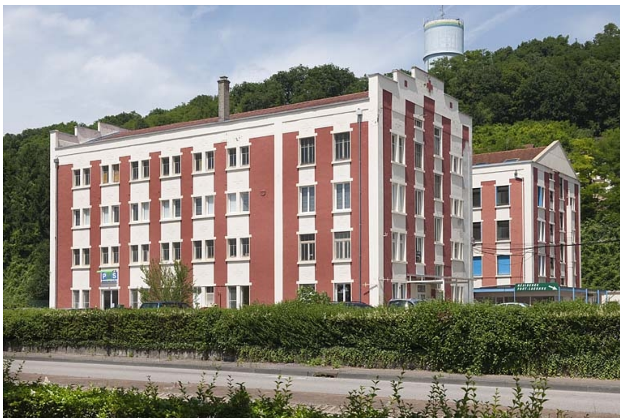
Immeuble de dortoirs. Vue depuis la route.
