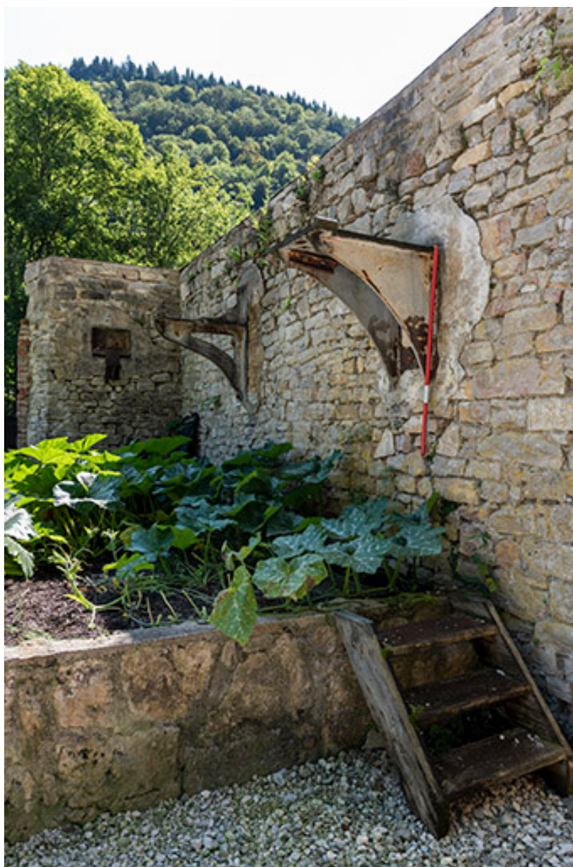
Vestiges de l'usine : supports de transmission.
