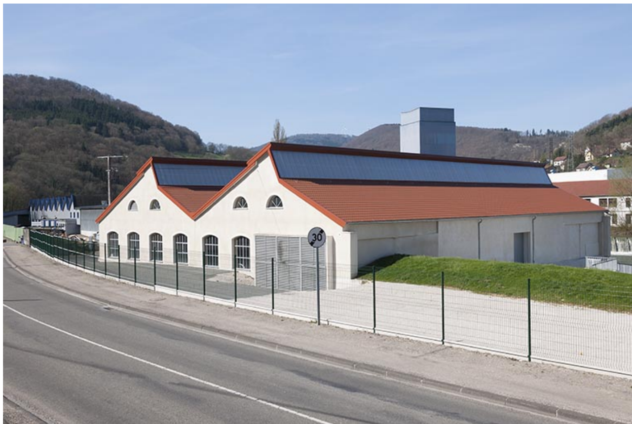
Centrale hydroélectrique (rive droite).
