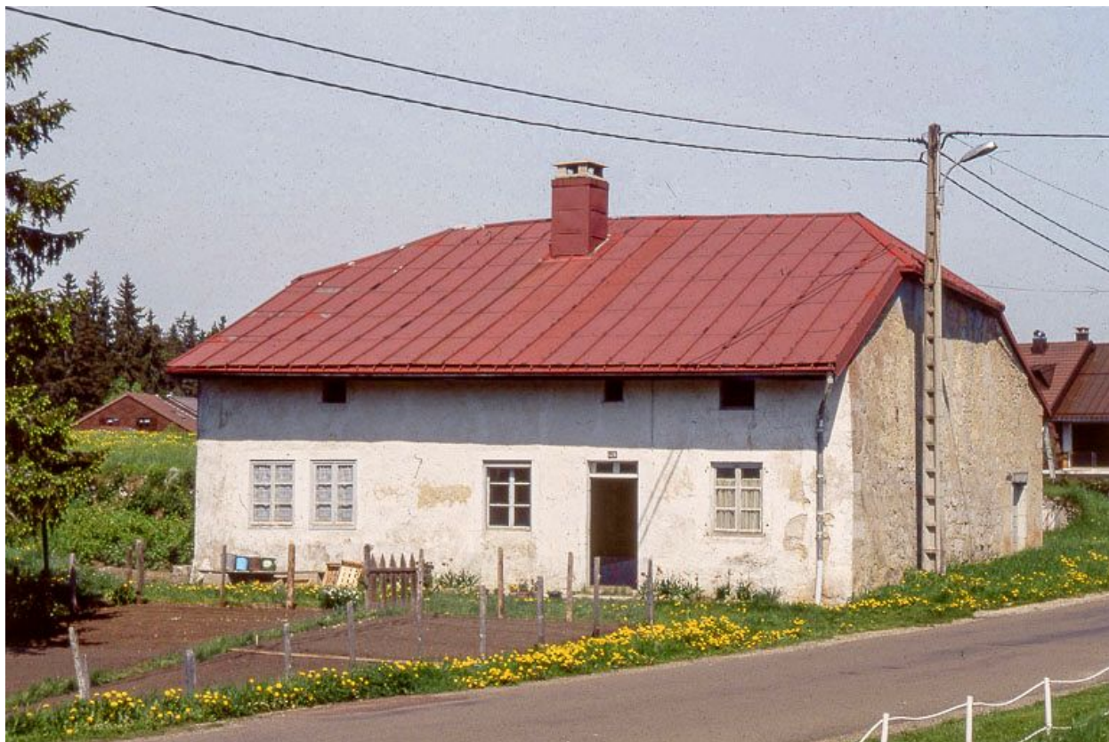
Façade antérieure et face droite.
