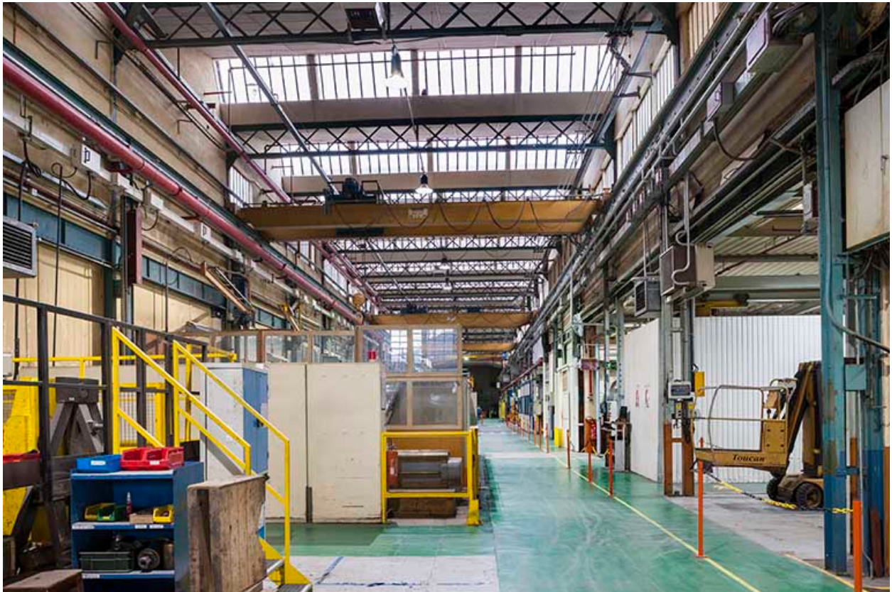
Hall central. Vue axiale.
