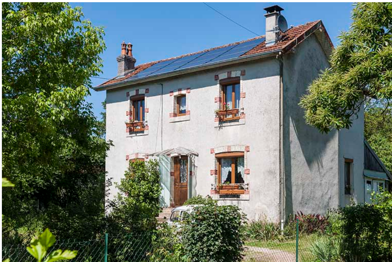
Maison située vers l'entrée du village.
