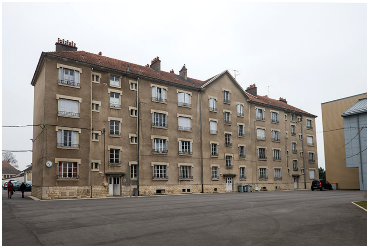
Façade antérieure sud-ouest des logements et administration.
