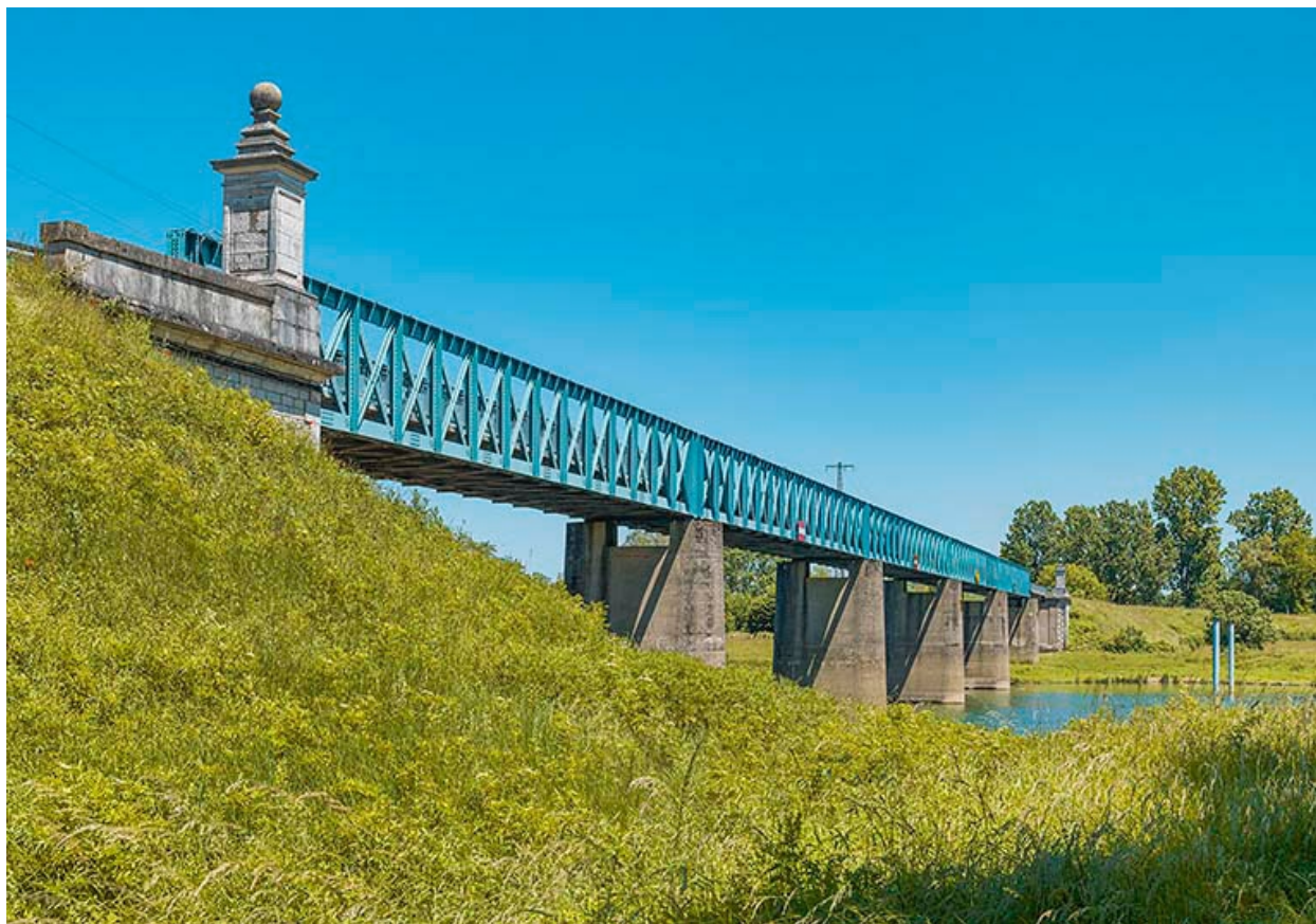
Vue d'ensemble du pont.
