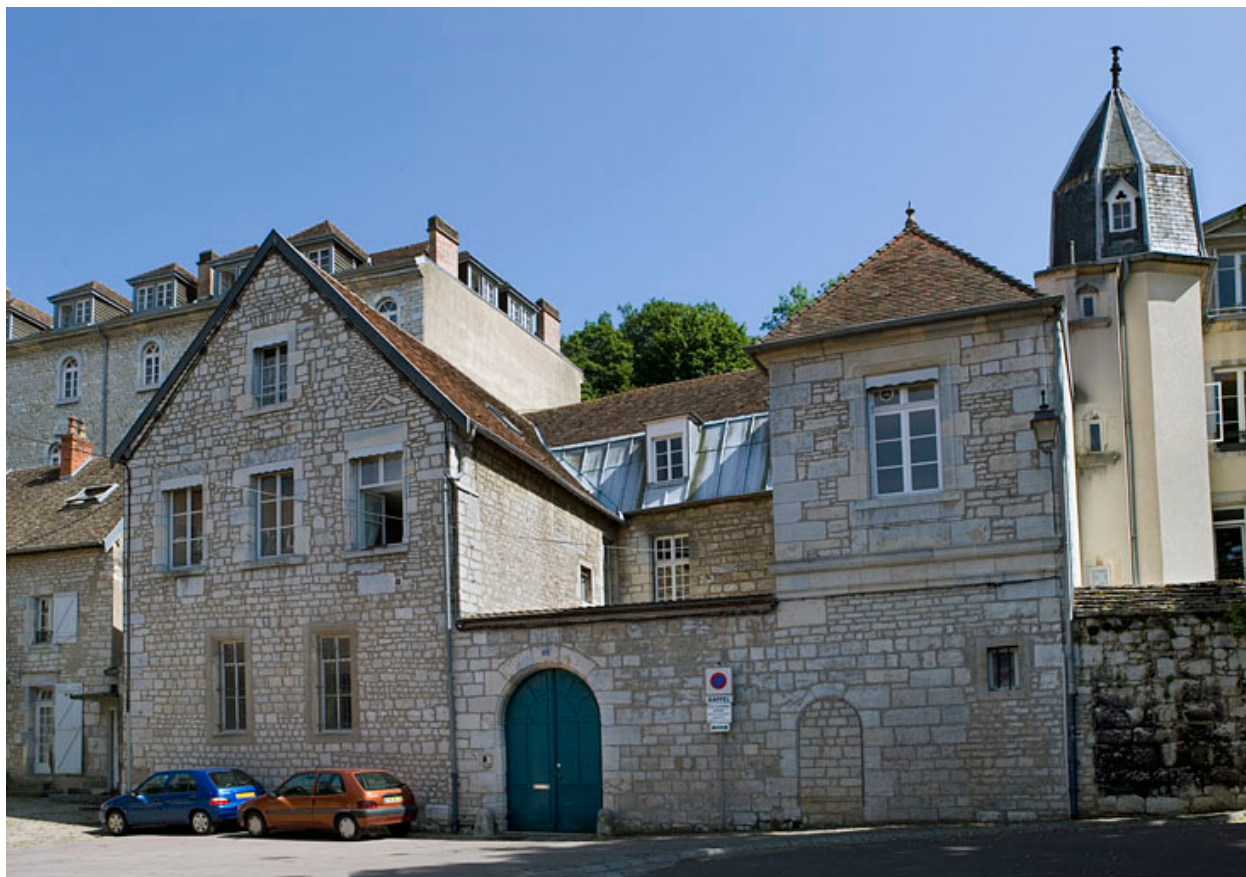
Vue d'ensemble depuis la rue.
