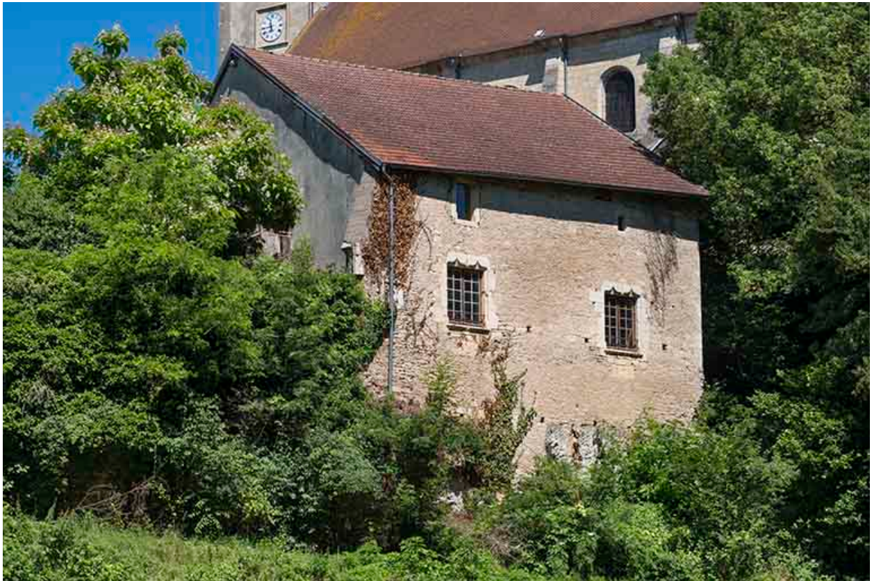
Façade postérieure de l'ancienne cure.
