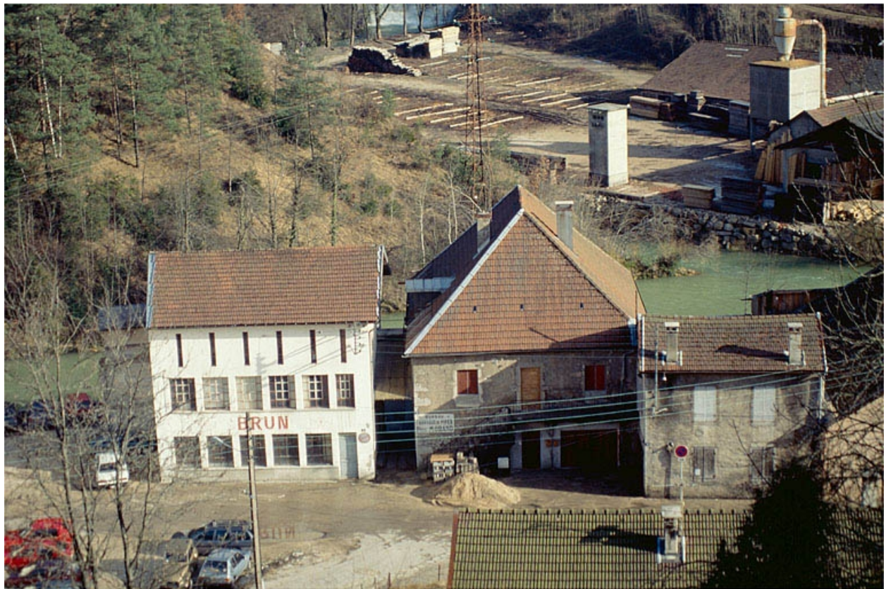
Façade antérieure des bâtiments.
