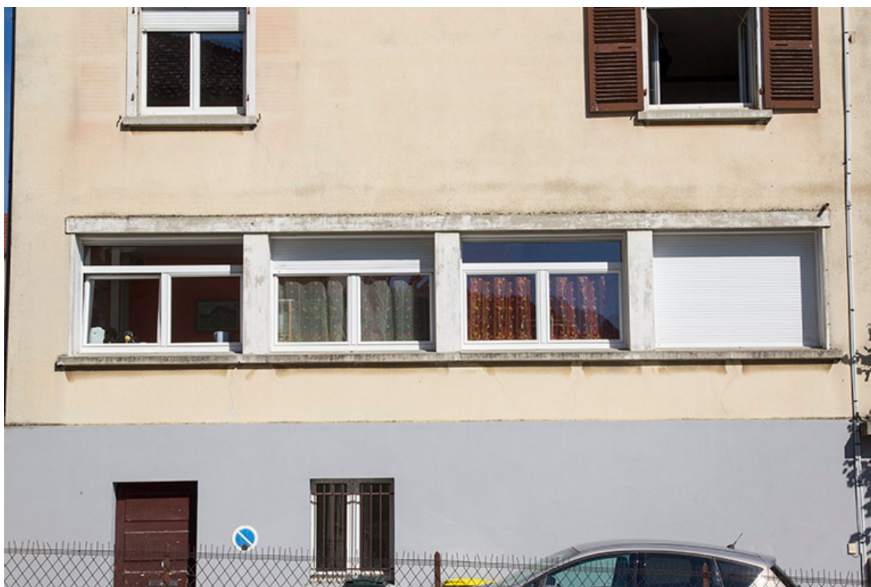
Façade latérale gauche : fenêtres d'atelier.
