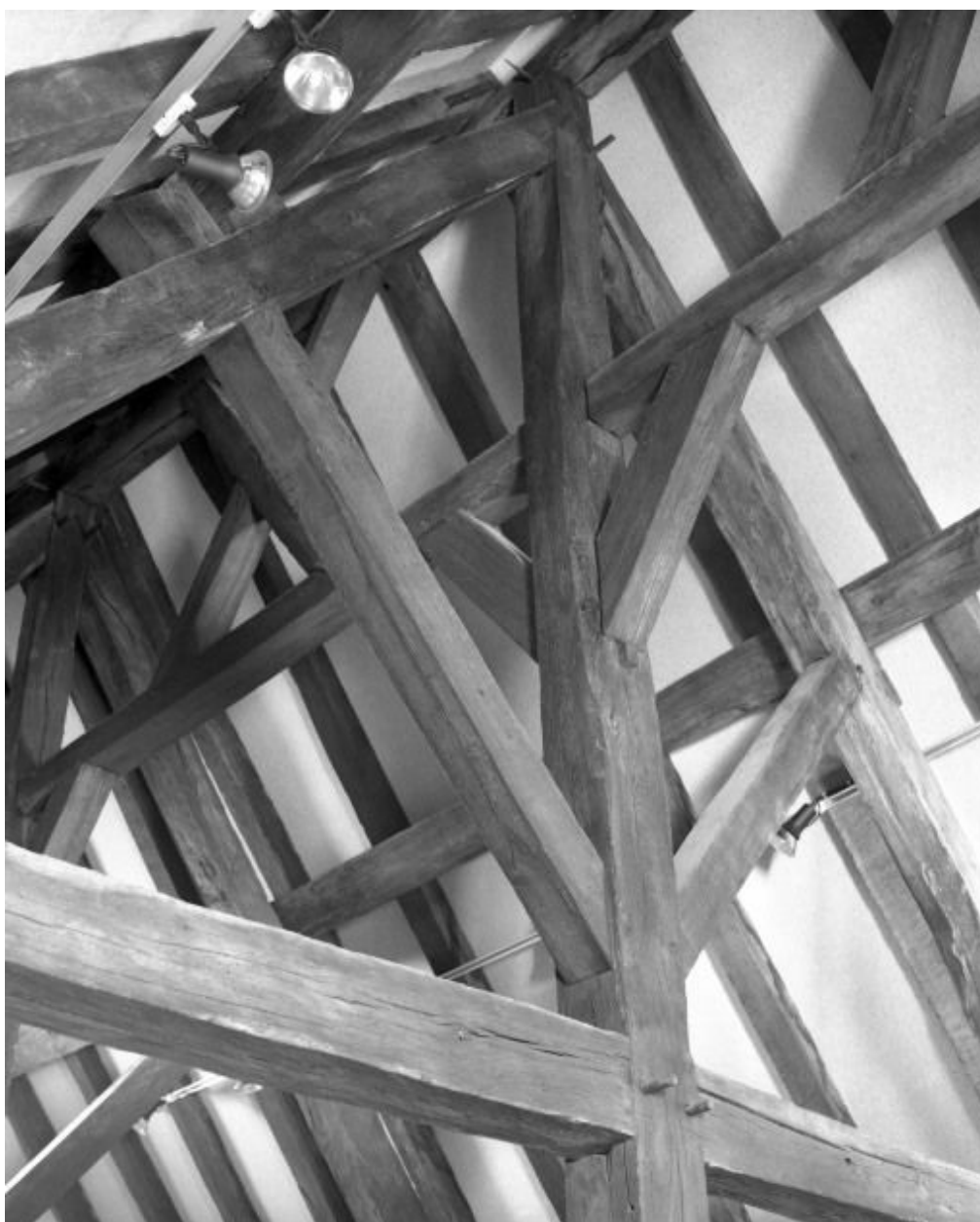
Charpente du niveau supérieur du comble.
