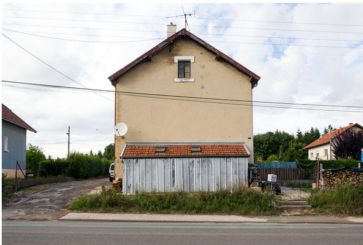
Immeuble au n° 7 : façade latérale sud.
