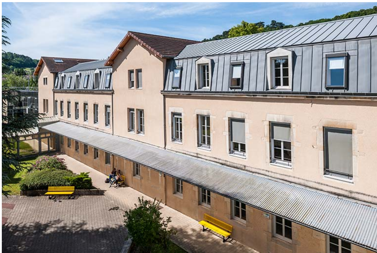
Façade Ouest sur cour de l'externat
