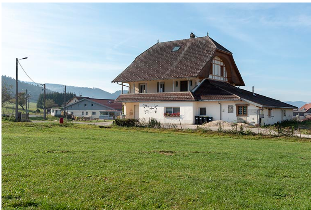
Façades postérieure et latérale droite.
