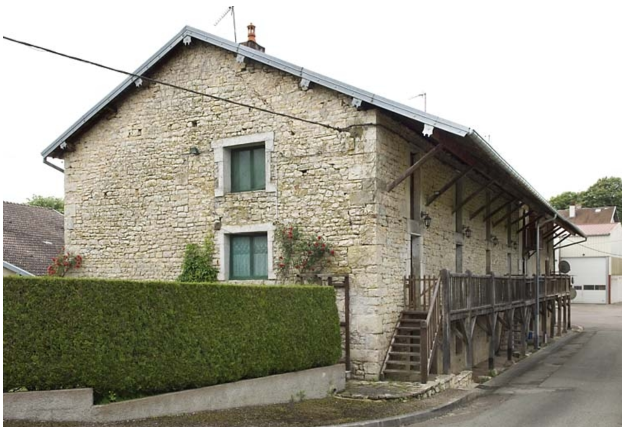
Façade sur rue du logement ouvrier.
