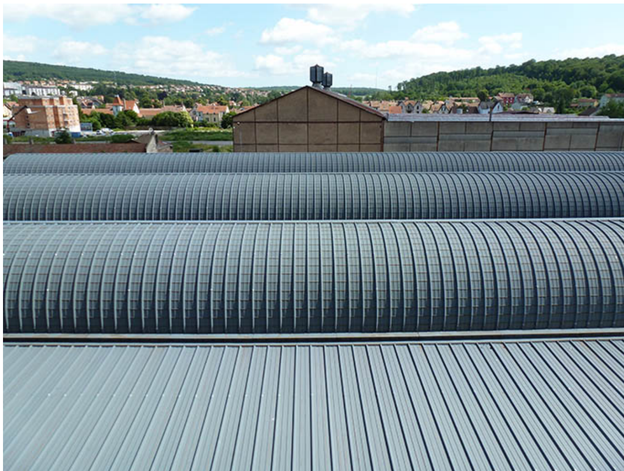
Toiture des ateliers.
