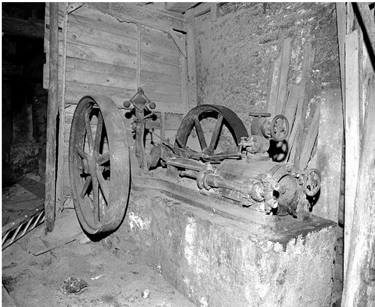
Vue d'ensemble de la machine à vapeur.
