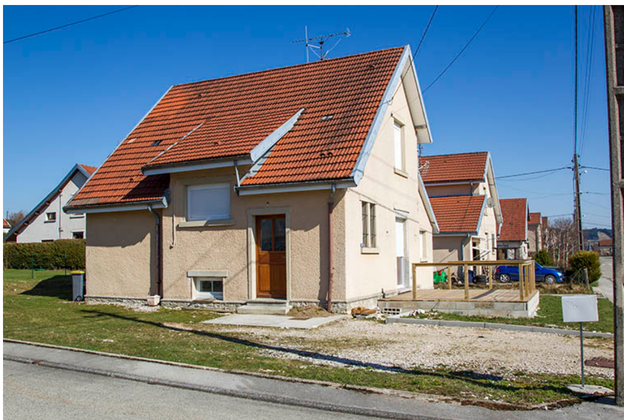
Façades latérale gauche et antérieure.
