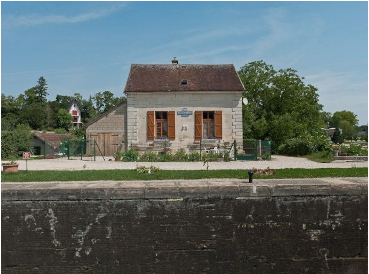
Vue de face de la maison éclusière.
