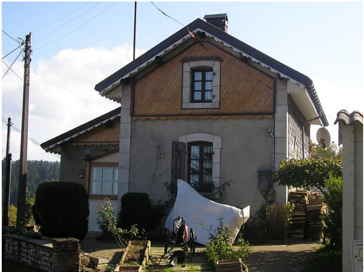
Vue latérale de la façade ouest.
