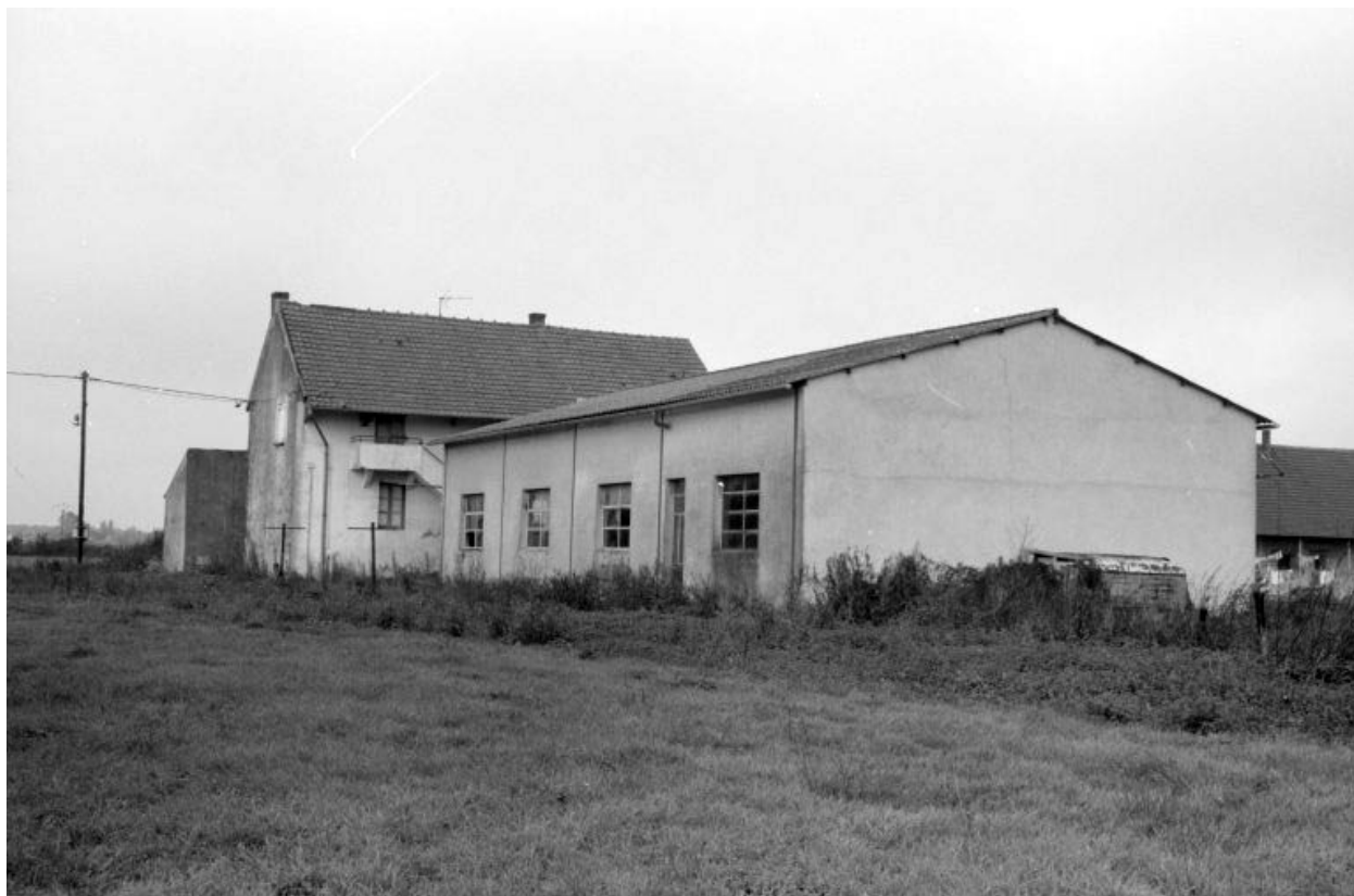
Nouvelle fromagerie, vue de l'est.
