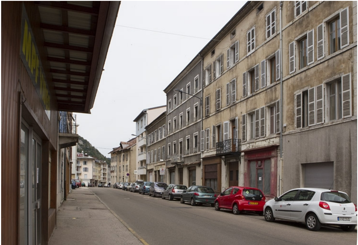
Elévation antérieure, de trois quarts droite.
