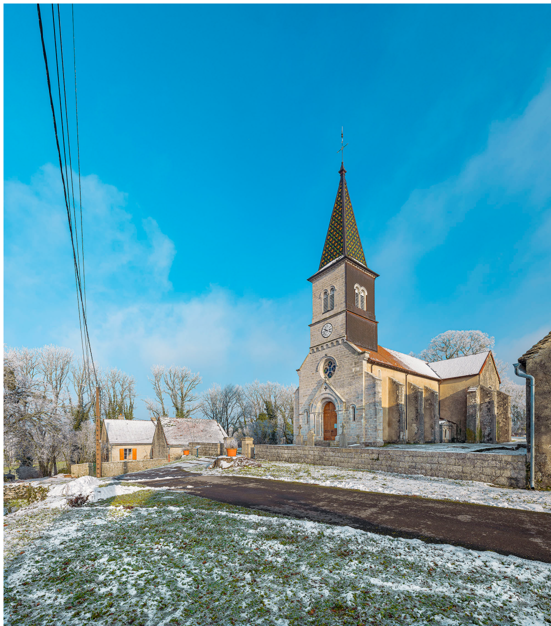
Vue d'ensemble de l'église, dans son environnement.
