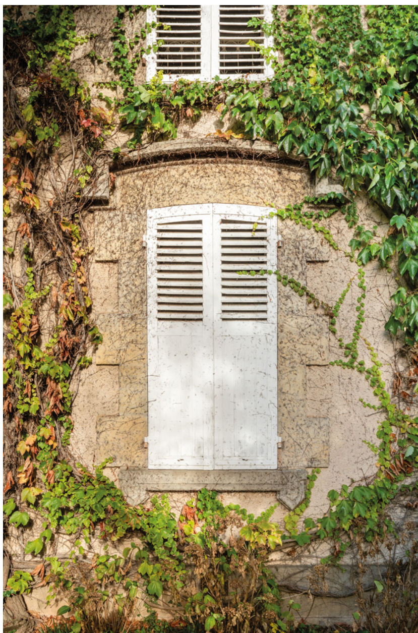
Logis. Fenêtre sur le pignon sud.
