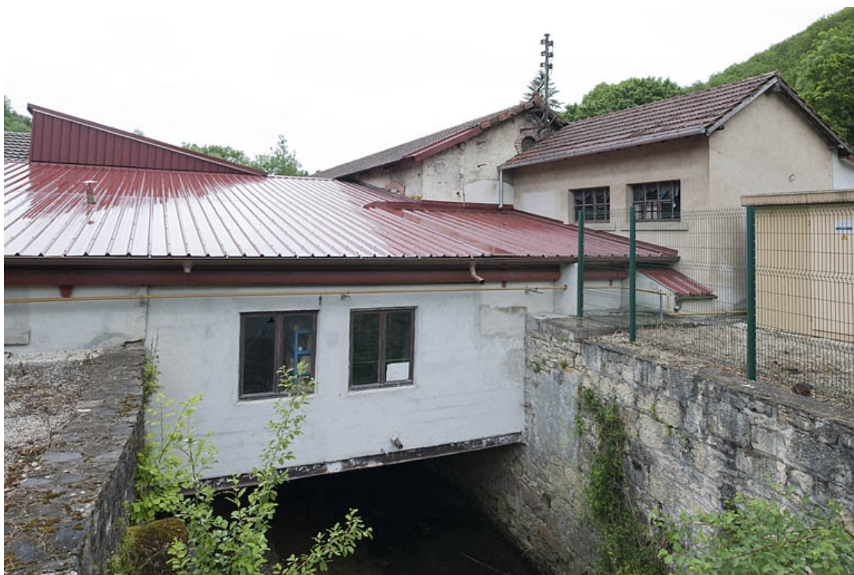
Bâtiment sur l'ancien bief de dérivation.
