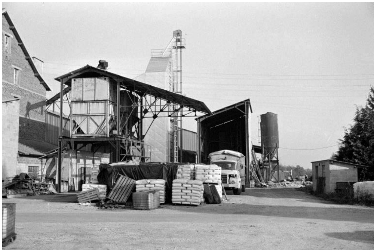
Poste de chargement, séchoir à grains et pont-bascule.
