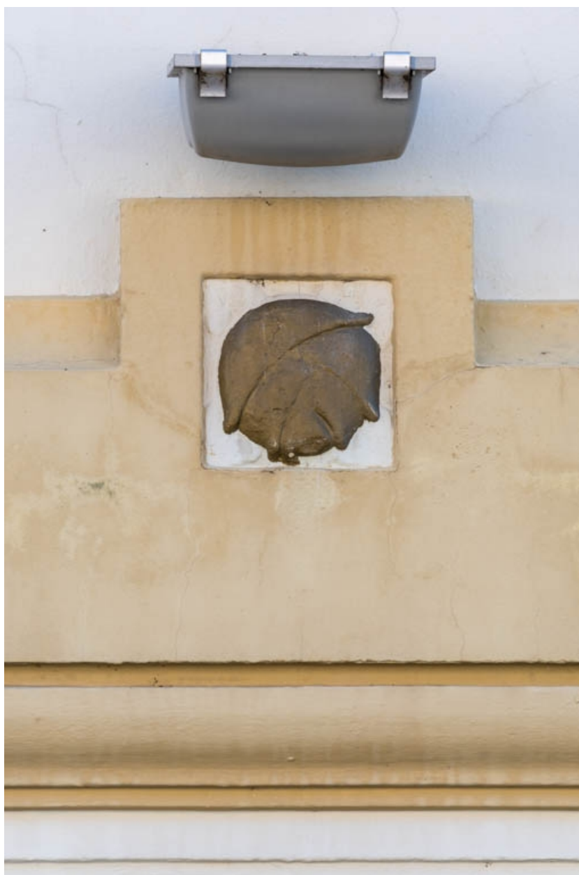
Façade antérieure : détail du décor.
