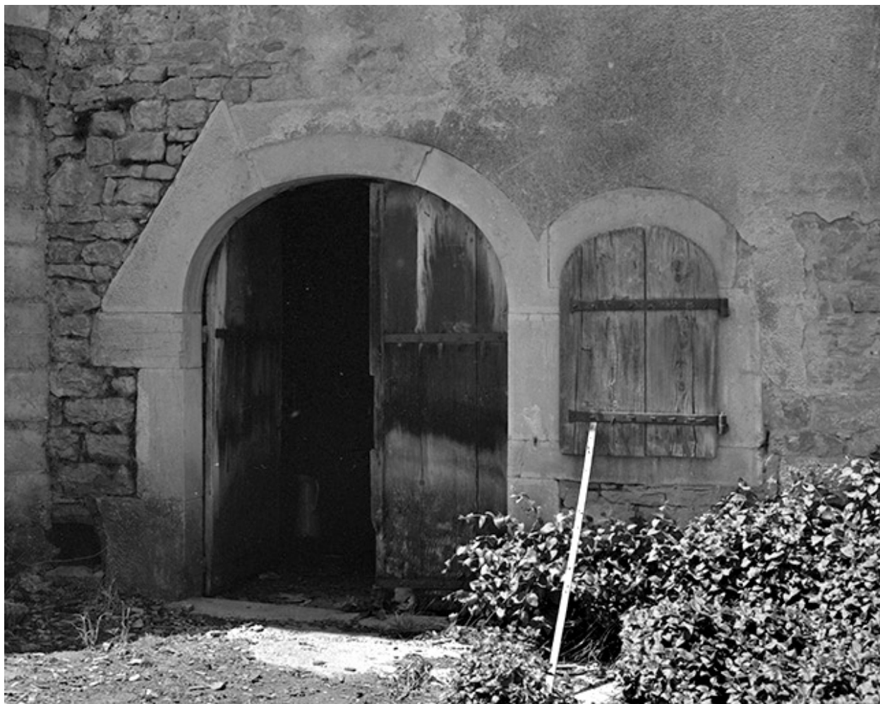
Détail : porte et fenêtre de l'étable.
