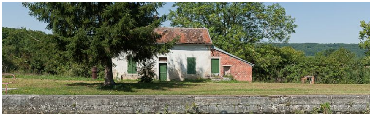
Vue de face de la maison éclusière.
