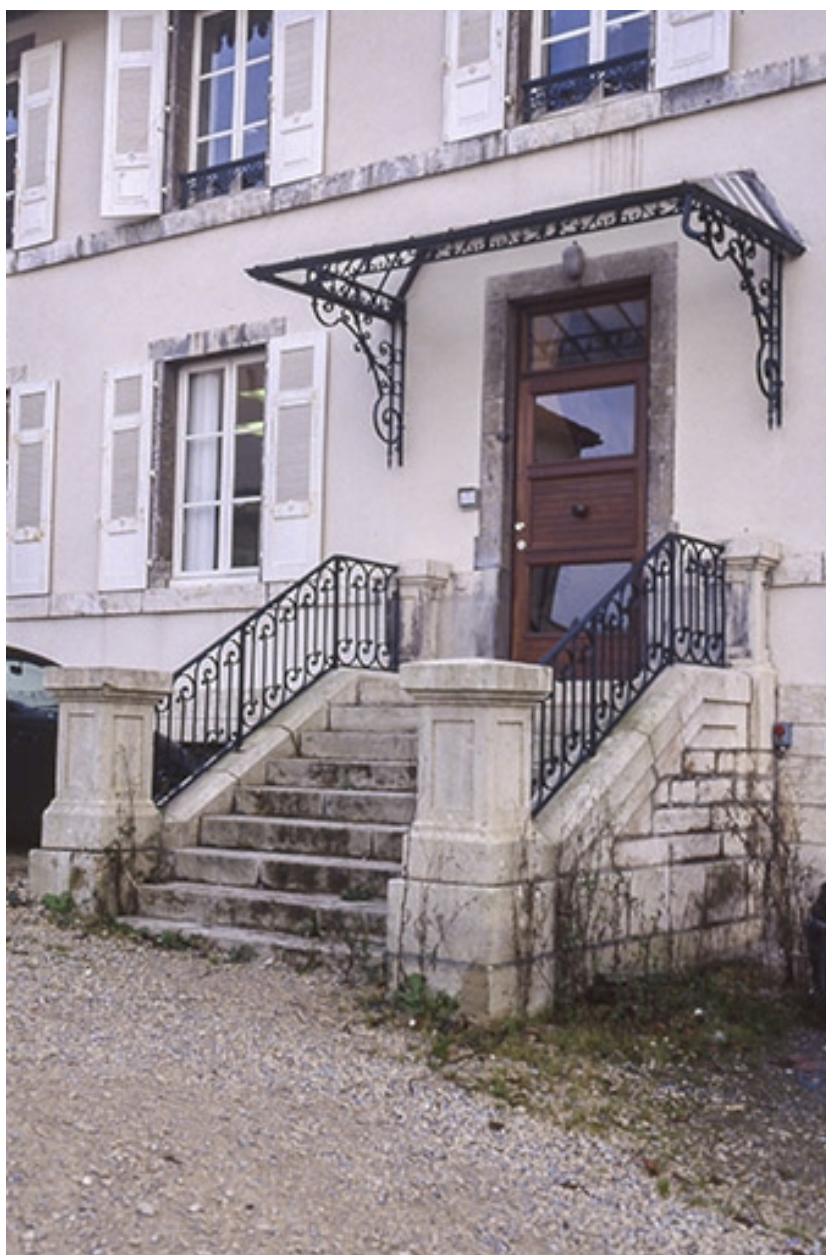
Perron du bâtiment des bureaux.
