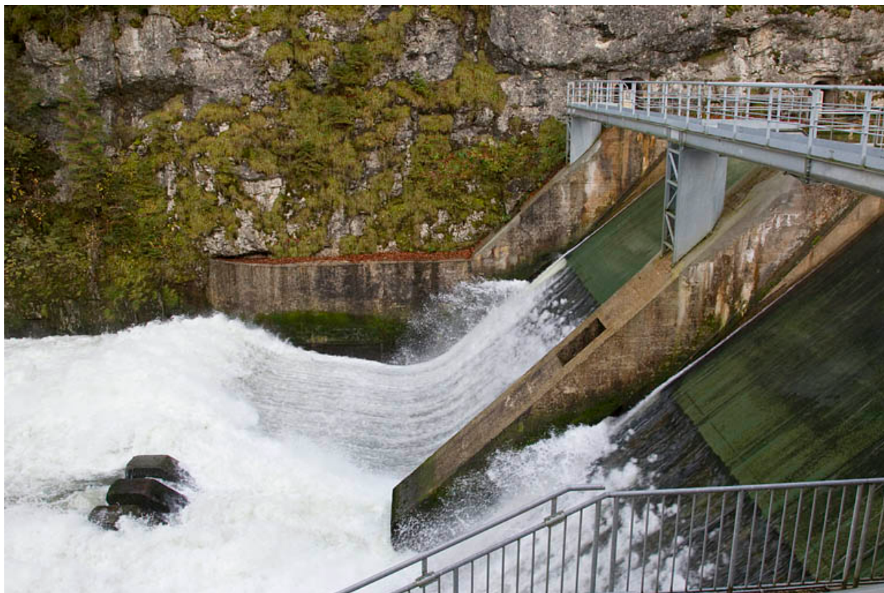
Barrage : vue plongeante sur les vannes toit.
