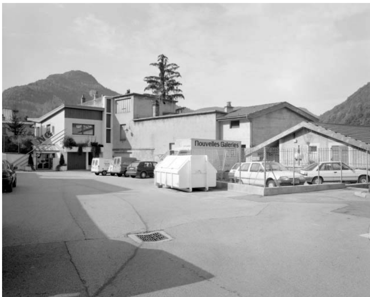
Façade orientale des bâtiments.
