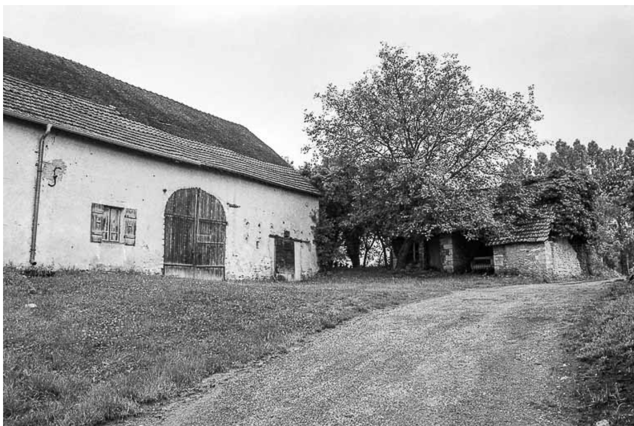
Façade antérieure : partie agricole.
