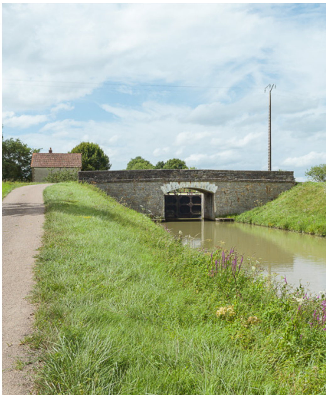
Vue d'ensemble du pont.
