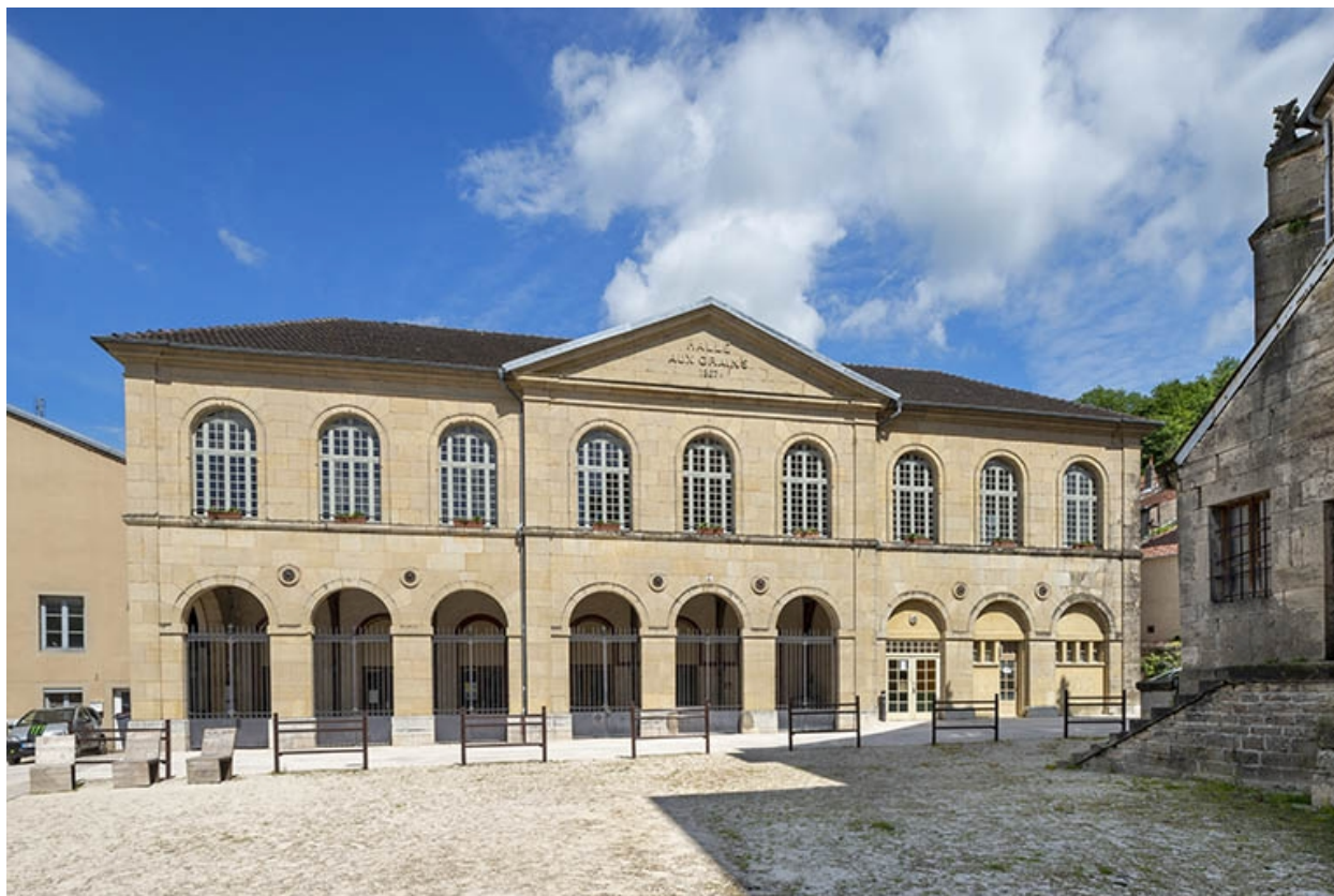
Vue de face de la halle.
