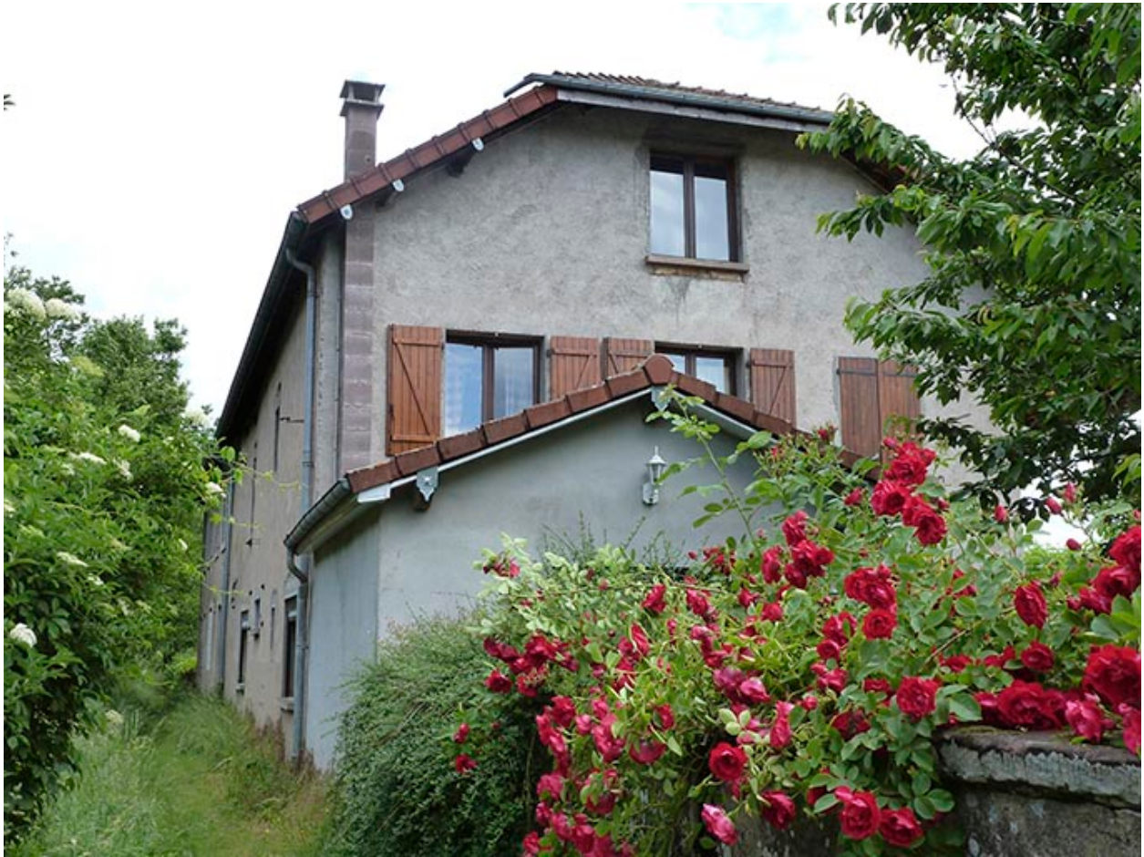
Bâtiment au long du canal : façade sud.
