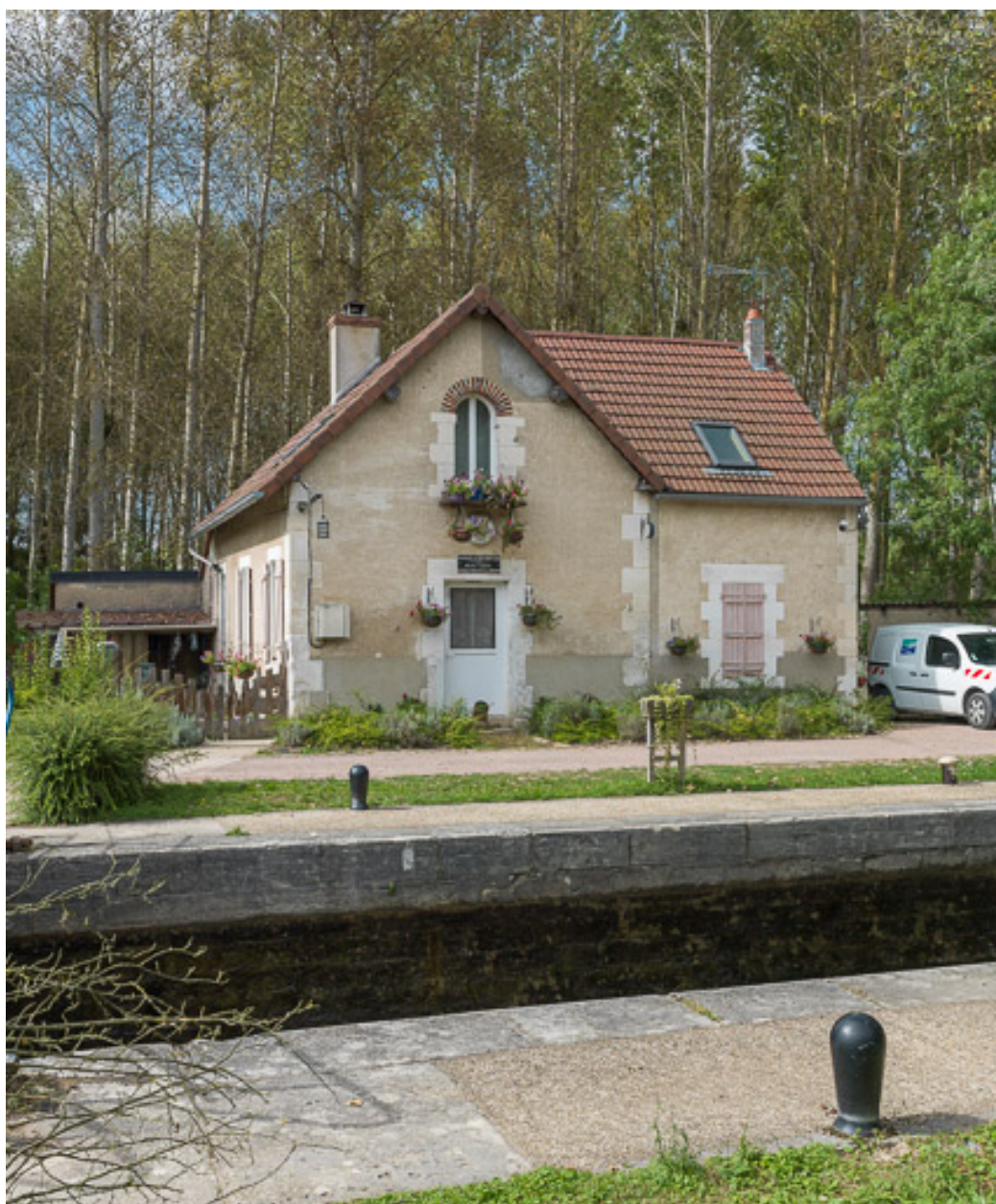
Vue de la maison éclusière.
