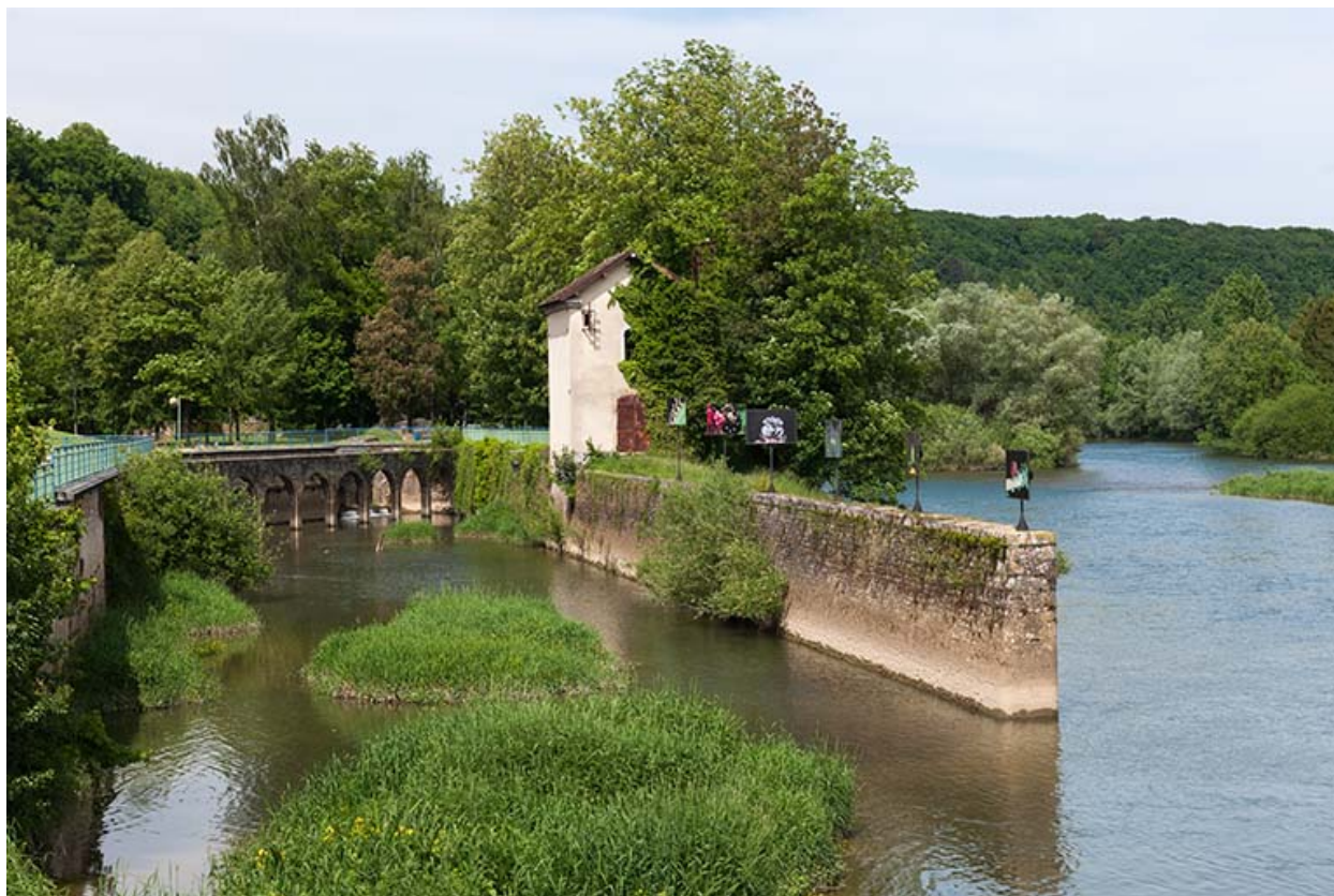
L'ancien canal de fuite et le transformateur.
